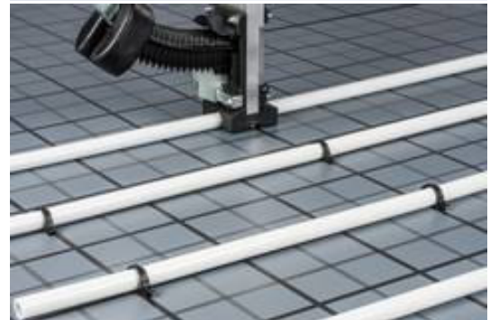
Rohrbefestigung mit Tackernadeln
